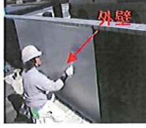
外壁・室内壁・ドアへの塗装施工
